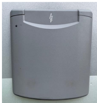
Aansluitpunt 220V buitenzijde
